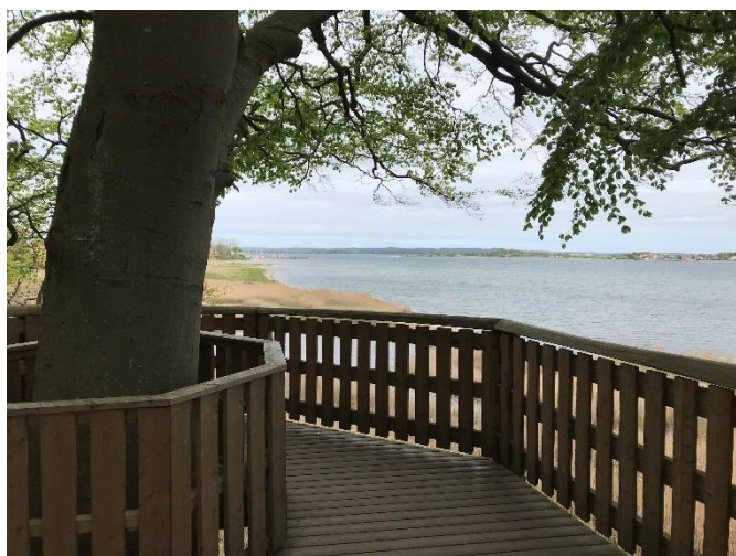
Udsigtsplatform ved Snaptun - 15 meter over havet
