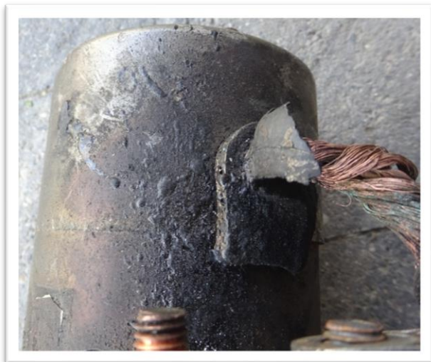
Isolering total smeltet omkring ledningsnet på gl. starter
