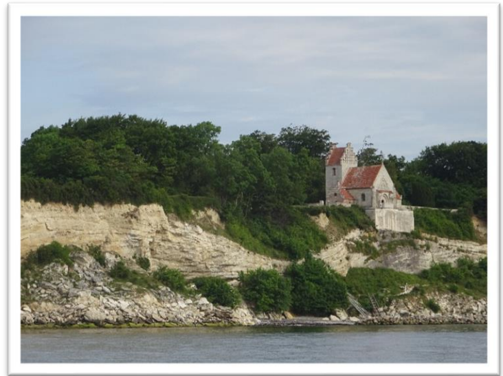
Sømand i et forlis lovede at bygge en kirke på stedet, hvis han blev reddet. Desværre forsvinder mere og mere af kysten og koret er allerede styrtet ned.
